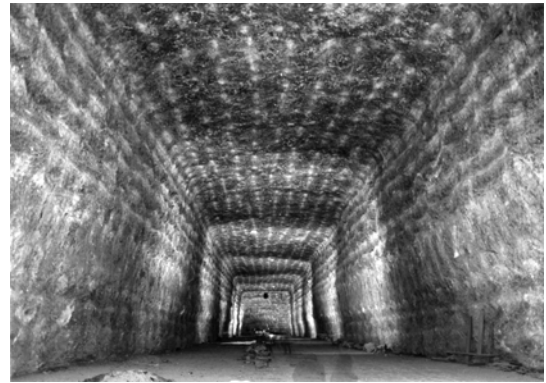
Abbaukammer im Heilbronner Salzbergbau Kochendorf.
